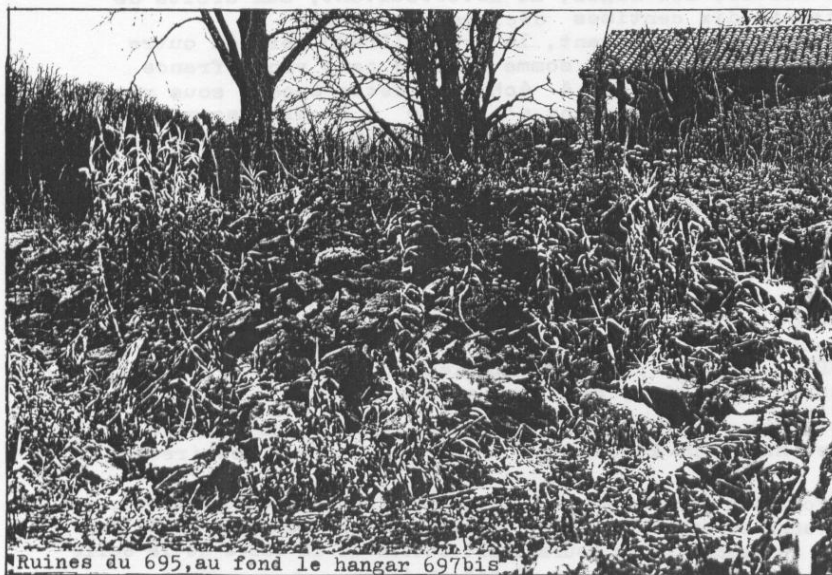
Ruines du 695, au fond le hangar 697bis
