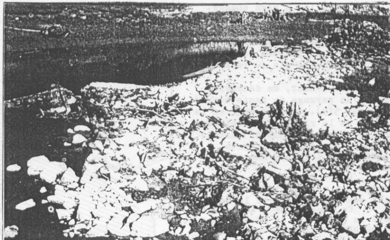
Ruines de la chaussée
